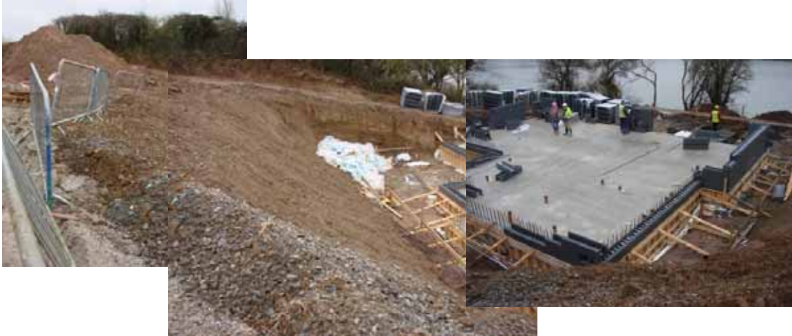
03.03.2010 ICF walls commence
